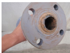
洗浄前の配管内
