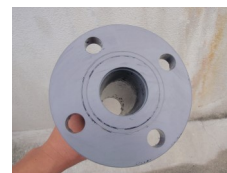
洗浄後の配管内
